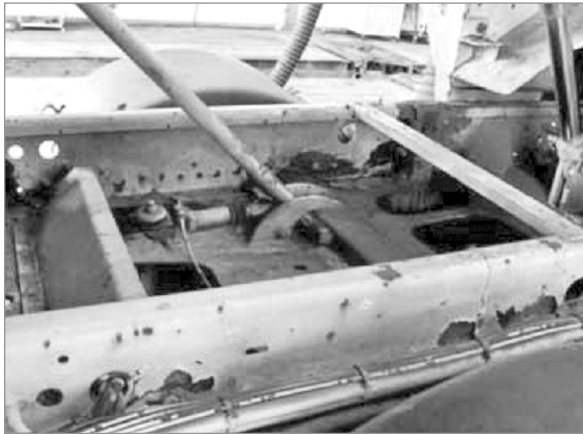
Soporte de seguridad en una superestructura vehicular elevada.
